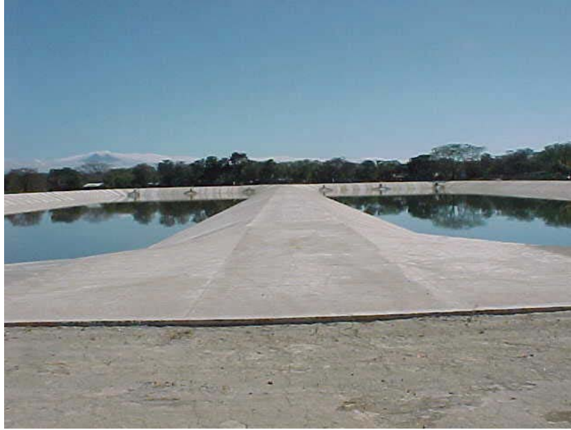
Las dos lagunas que se construyeron en 1999, tienen todo el talud interno de concreto. Son las lagunas primarias.
