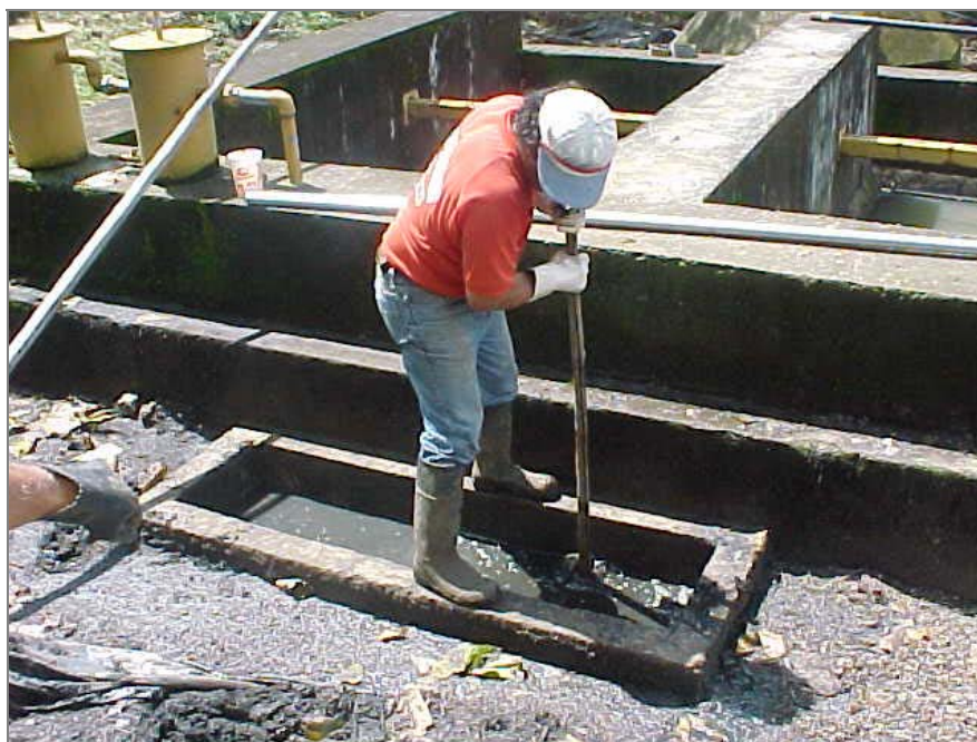
Desobstrucción de la Caja Distribuidora de Caudales
