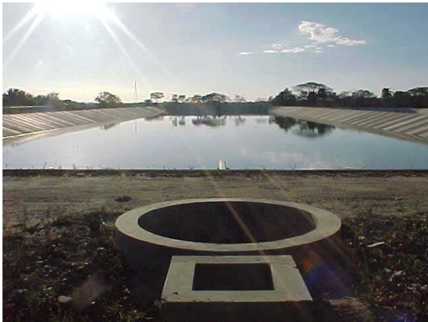
La caja de distribución de caudales No.2 distribuye el caudal en partes iguales a cada una de las tres tuberías de entrada de la laguna.
