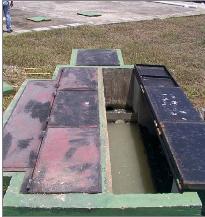
Estructura de Medición y Distribución de Caudales
