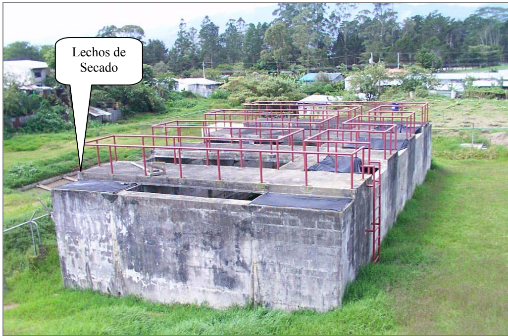
Biodigestor y Lechos Secado
