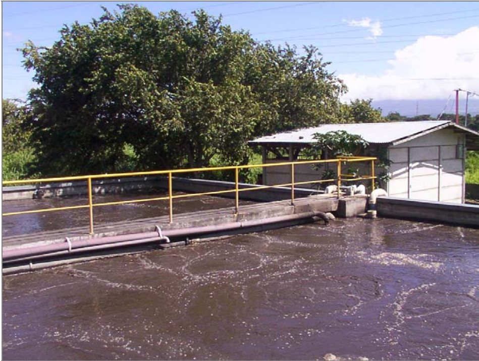
Tanque de Aireación y Caseta de Sopladores
