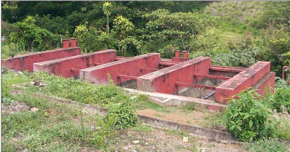
Fotografía 2. Reactor Anaerobio de Flujo Ascendente (UASB)
