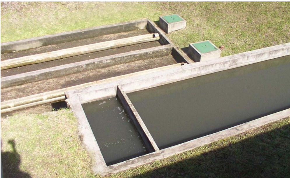
Sedimentador secundario y lechos de secado (1 er muestreo)
