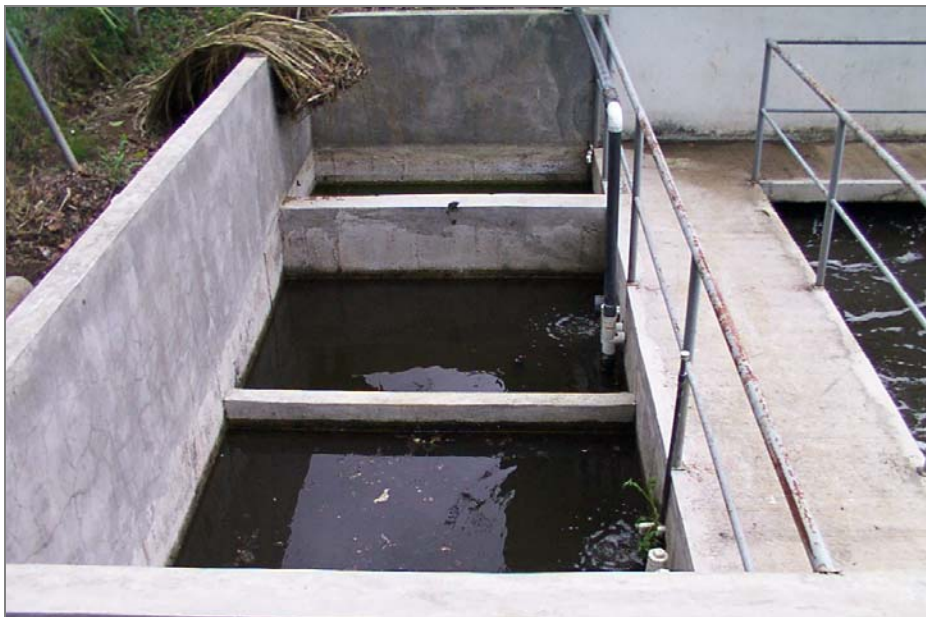
Sedimentador Secundario y Biodigestor
