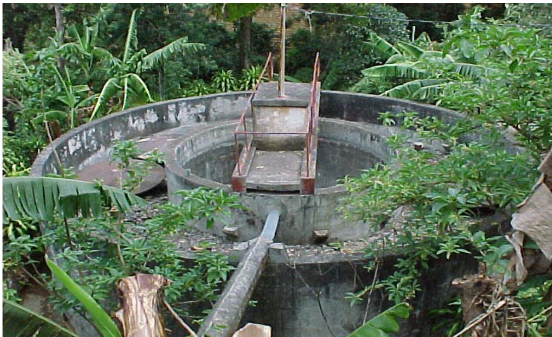
Tanque de aireación y filtro.
