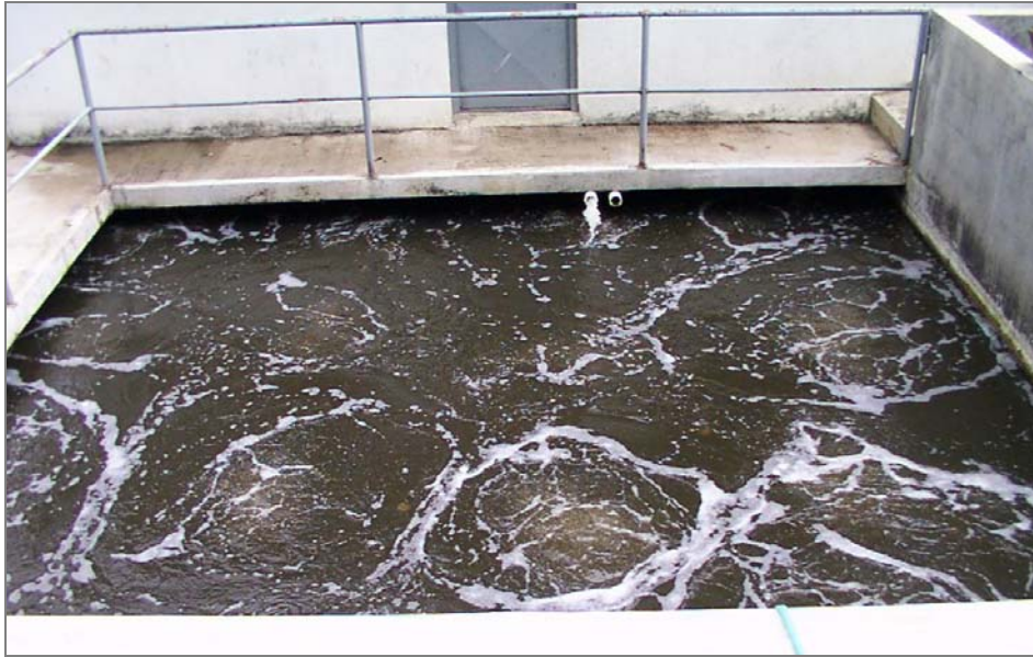
Tanque de Aireación
