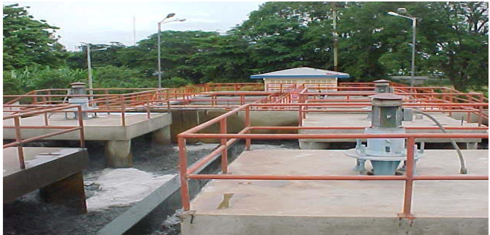
Tanques de aereación. La aereación se lleva a cabo mediante 6 mezcladores superficiales
