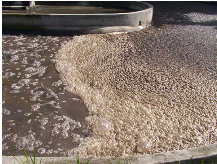
Aspecto de la nata acumulada en el canal de oxidación (2 do muestreo)
