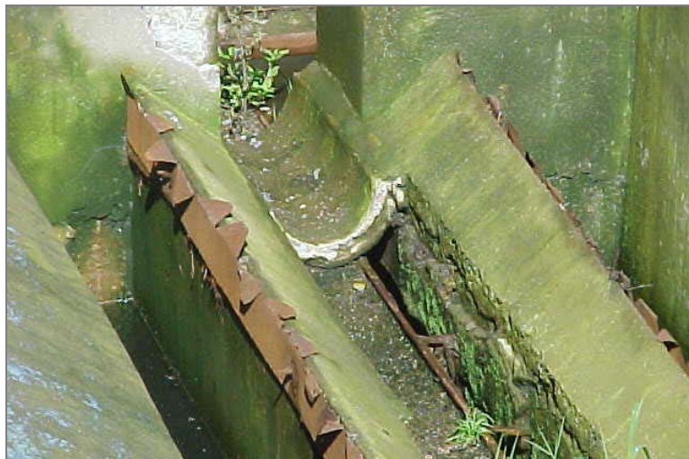
Canal de Recolección del Efluente del UASB
