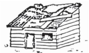
**5. Material de desecho:** techo construido con base en elementos usados o poco durables como cartón, latas viejas, sacos, etc. No ubicar material de desecho en otro.
