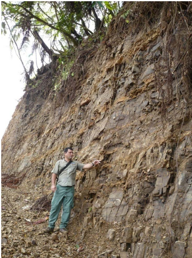
Afectación de suelos. Varias capas de suelo se removieron para abrir el camino en este sector de San Josecito, con evidente afectación ambiental.
