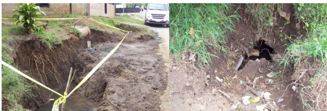
**Foto 5:** Sector de calle Manantiales en Santo Domingo, ruptura del alcantarillado por presión del agua.
