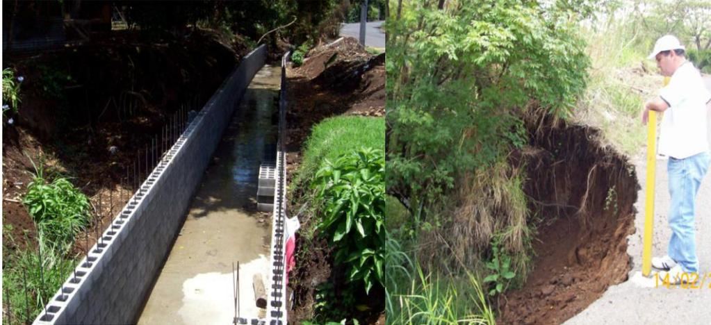
**Foto 7:** Sector de La Quintana, se observa la canalización de las aguas y socavamiento del camino.
