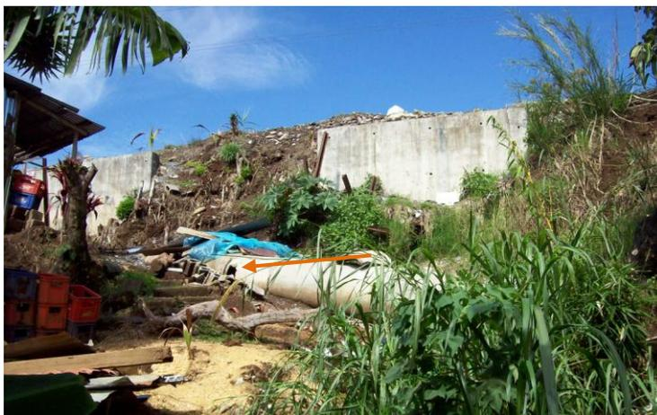
**Foto 6:** Sector de San Martín, tubería quebrada que provoca escorrentía superficial ocasionando peso en los muros de contención.
